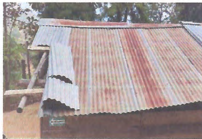
Foto 1: CUBIERTA DE LAMINA
