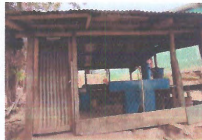
Foto 2: Reparacion del area de cocina
